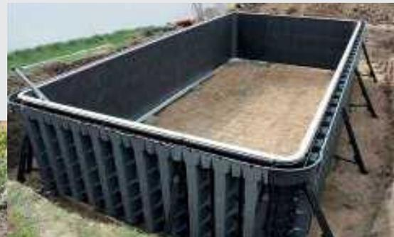
Installation der Fundamentsteine. Anschließend erfolgt die Montage der im Werk vorgefertigten Verschalung.
