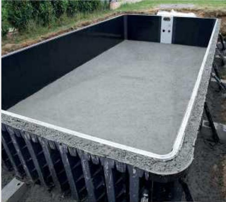
Zunächst erfolgt die Armierung des Bodens und der Kamine, sowie des oberen und unteren Ringankers. Das Betonieren der selbst tragenden Verschalung erfolgt aus einem Guss. Die Ausgleichsschicht sorgt am Boden für den letzten Schliff.
